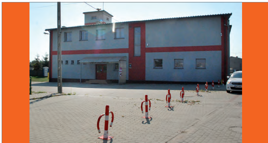
Ograniczniki ruchu przy Ochotniczej Straży Pożarnej.
