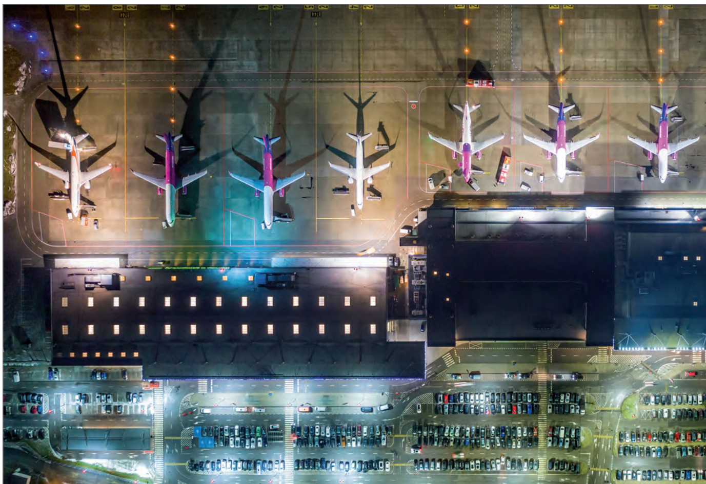
W czerwcu 2015 roku w Pyrzowicach uruchomiono trzeci terminal pasażerski. W obiekcie obsługiwany jest ruch przylotowy.
