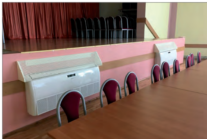
Klimatyzacja w sali tanecznej Ochotniczej Straży Pożarnej.
