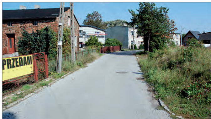
...i po remoncie (od strony DK 78).
