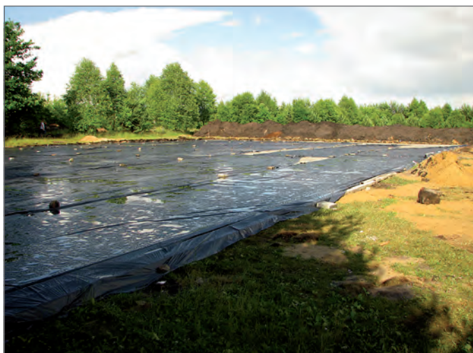
Boisko wielofunkcyjne w trakcie budowy.
