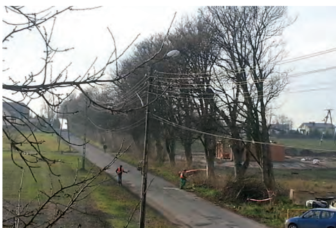
Przed przebudową sieci energetycznej przy ulicy Kopernika.
