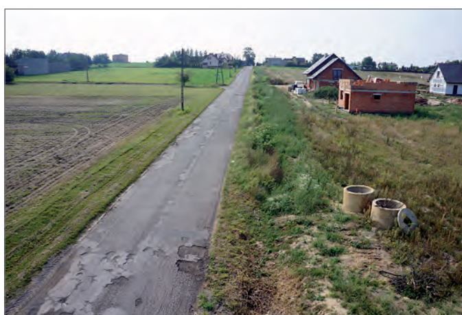
Po przebudowie sieci energetycznej przy ulicy Kopernika.
