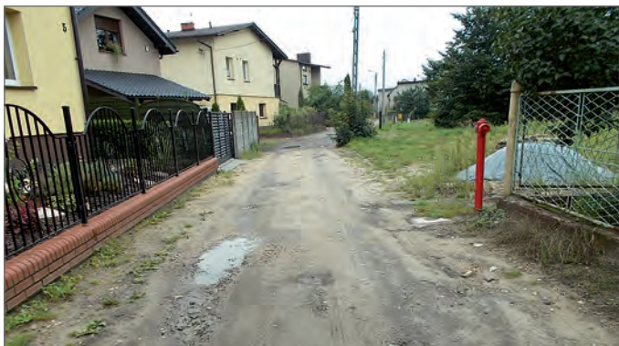
Ulica Kępna przed remontem...
