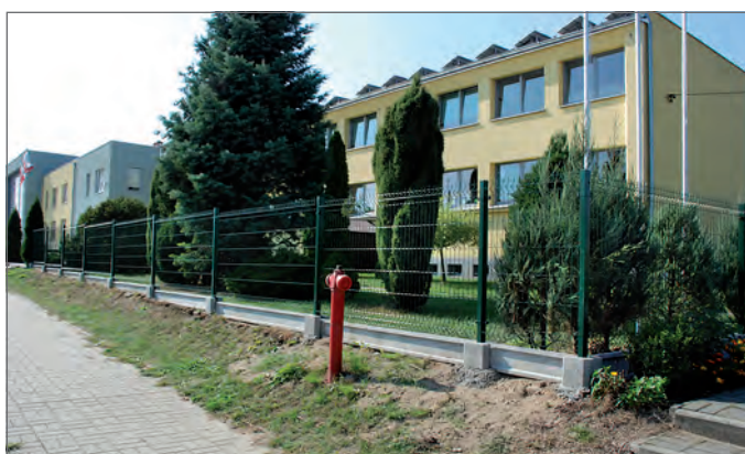
Ogrodzenie systemowe przy szkole podstawowej.
