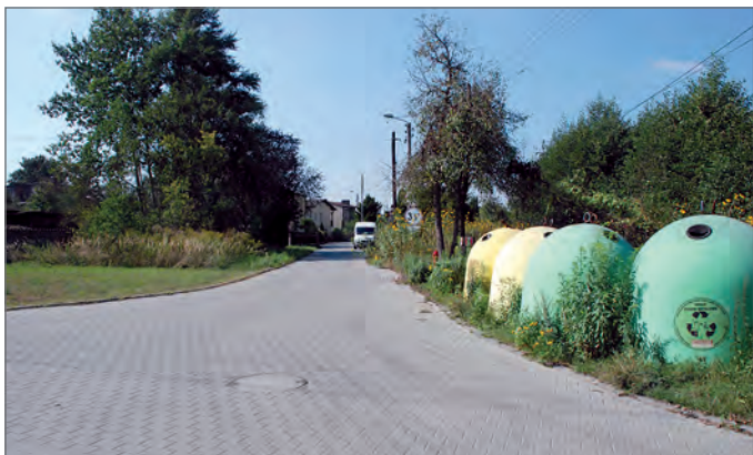
Ulica Kępna po remoncie.
