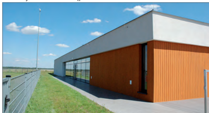
Budynek zaplecza sportowego przy boisku z bieżnią w Ożarówicach.
