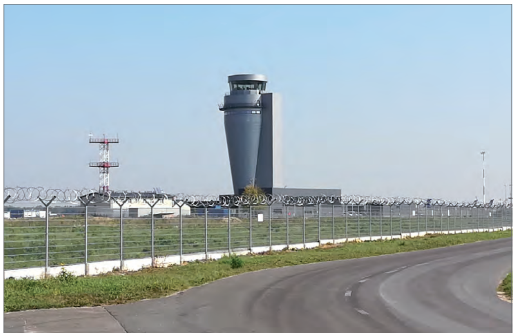
W tym roku oddano do użytku liczącą 46 m wysokości wieżę kontroli lotów.
