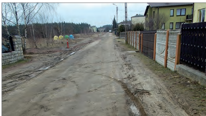
Ulica Nowowiejska przed remontem.
