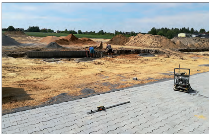
Centrum wsi w trakcie przebudowy.
