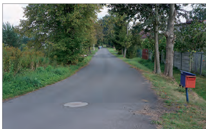
Ulica Jasionek po remoncie.
