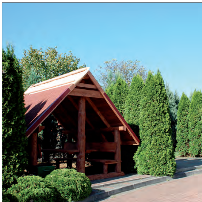
Montaż altan w Ożarówicach.
