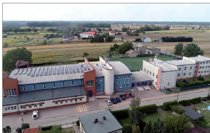
Budynek szkoły podstawowej.
